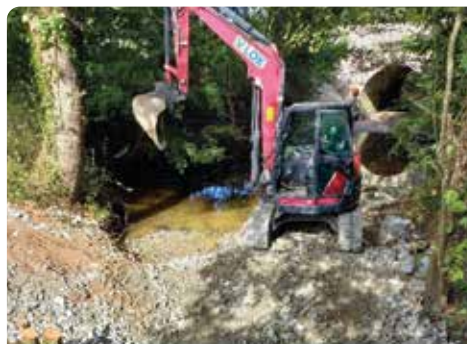
Recharge de radiers pont de Landefrère
