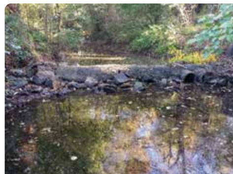
Enlèvement d'un seuil en amont du pont
