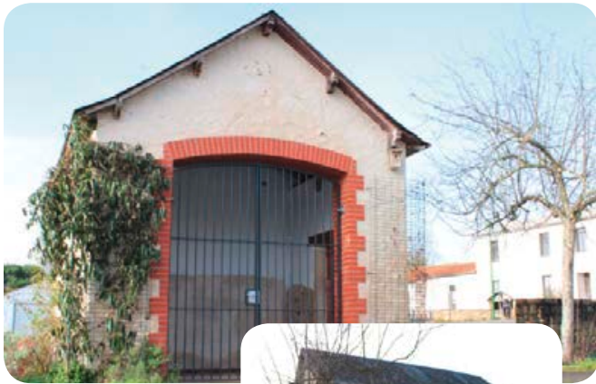
Rénovation de l'alambic par l'association « Bouaine Patrimoine », Place du Champ de Foire.
