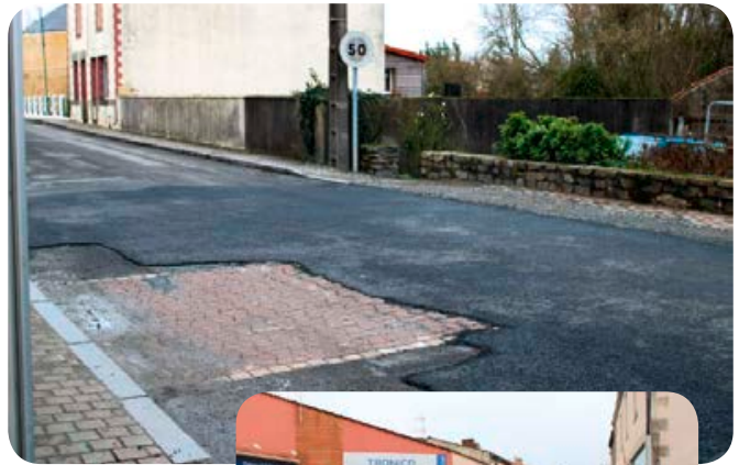
Démarrage courant septembre des travaux de réfection rue du Bocage.
